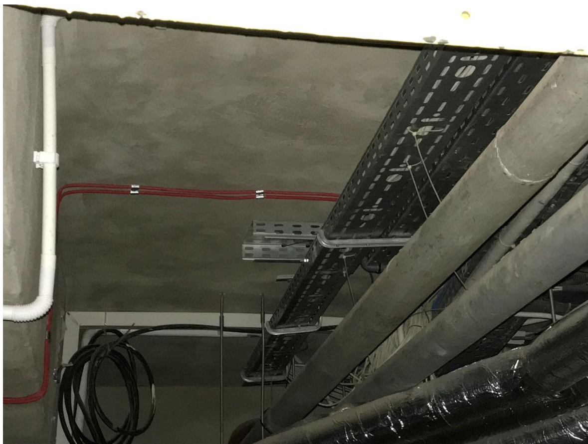
Fot. F-4 Widok od spodu płyty stropowej PŁ2
