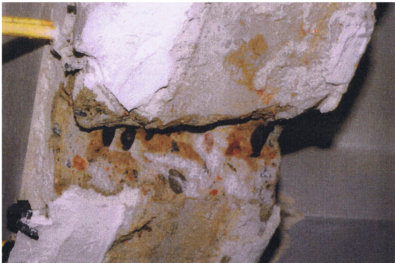
Fot. F-7 Podciąg monolityczny P1-odkrywka nr1
