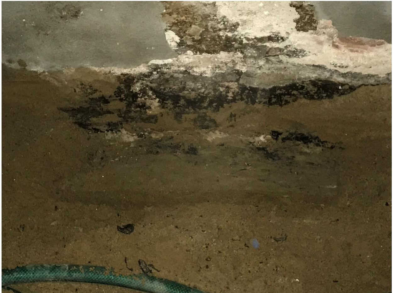
Fot. F-10 Widok rusztu żelbetowego stanowiącego oparcie dla ściany ceramicznej S1
