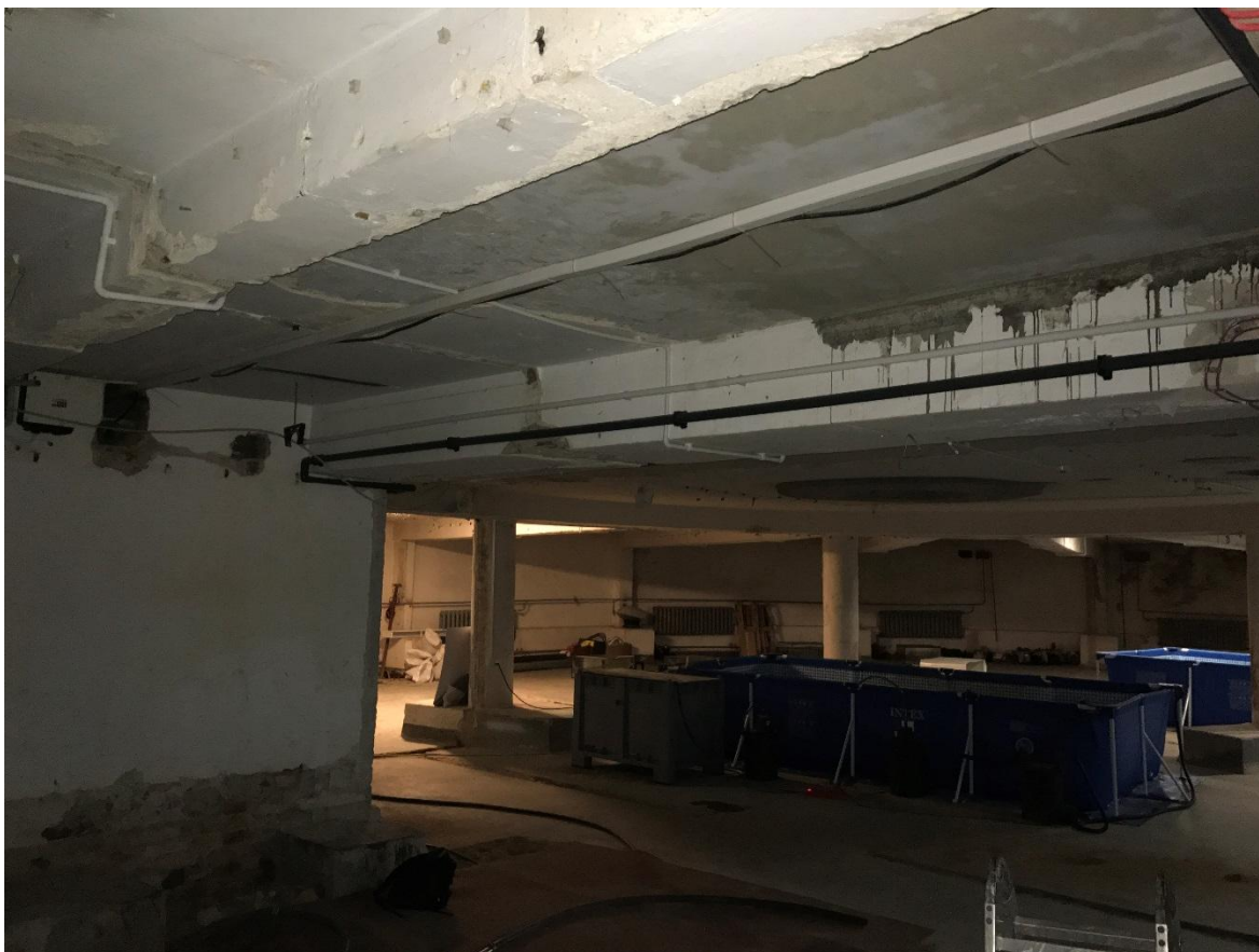
Fot. F-3 Widok podciągu monolitycznego P2
