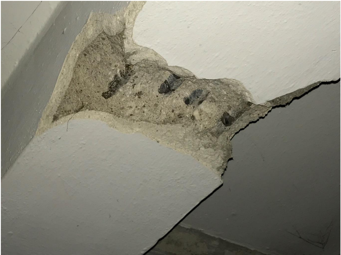
Fot. F-5 Belka monolityczna B1-odkrywka nr2
