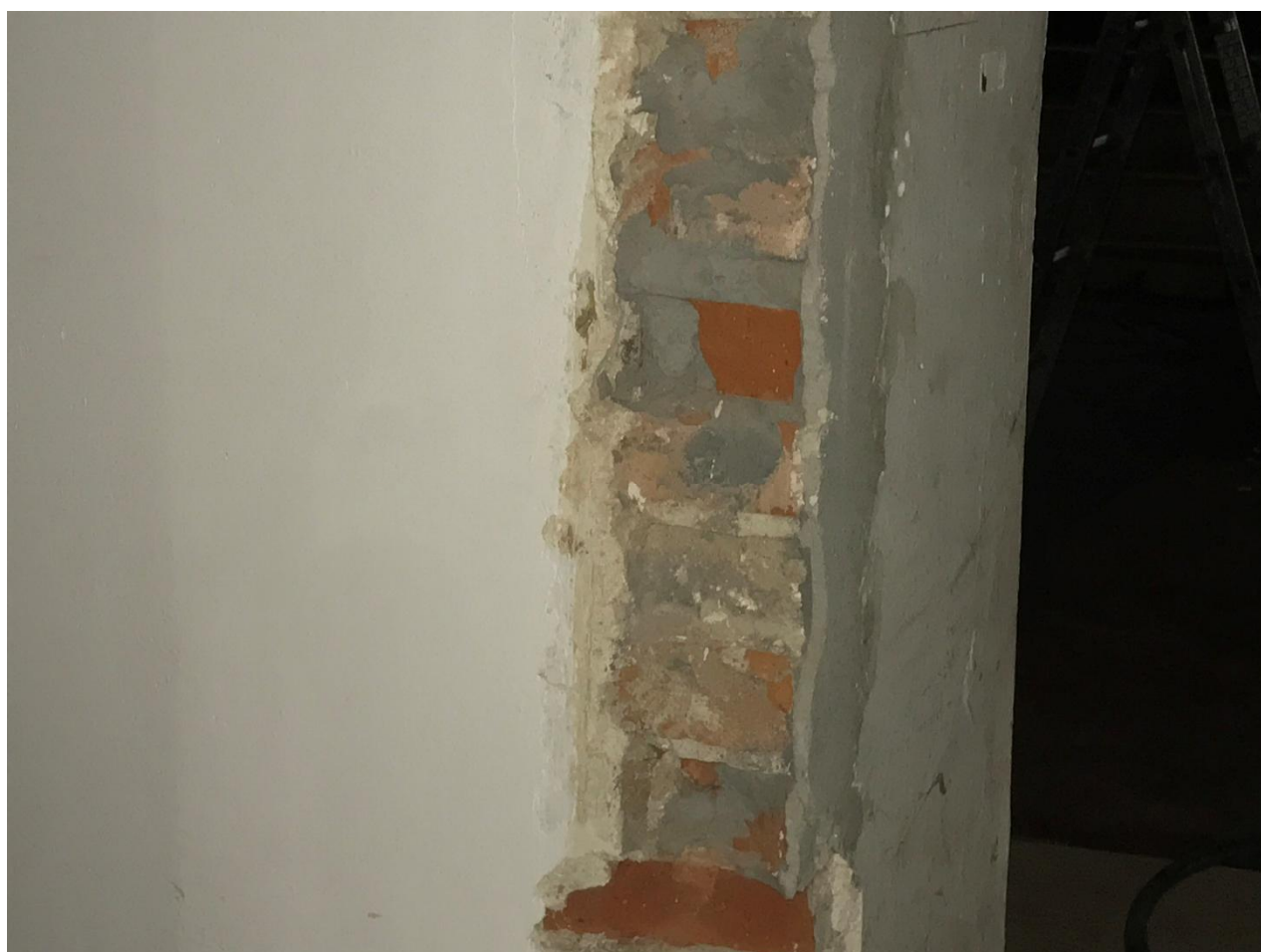
Fot. F-8 Ściana ceramiczna S1-widoczne wypełnienie ściany elemen. konstrukcyjnym z cegły pełnej
