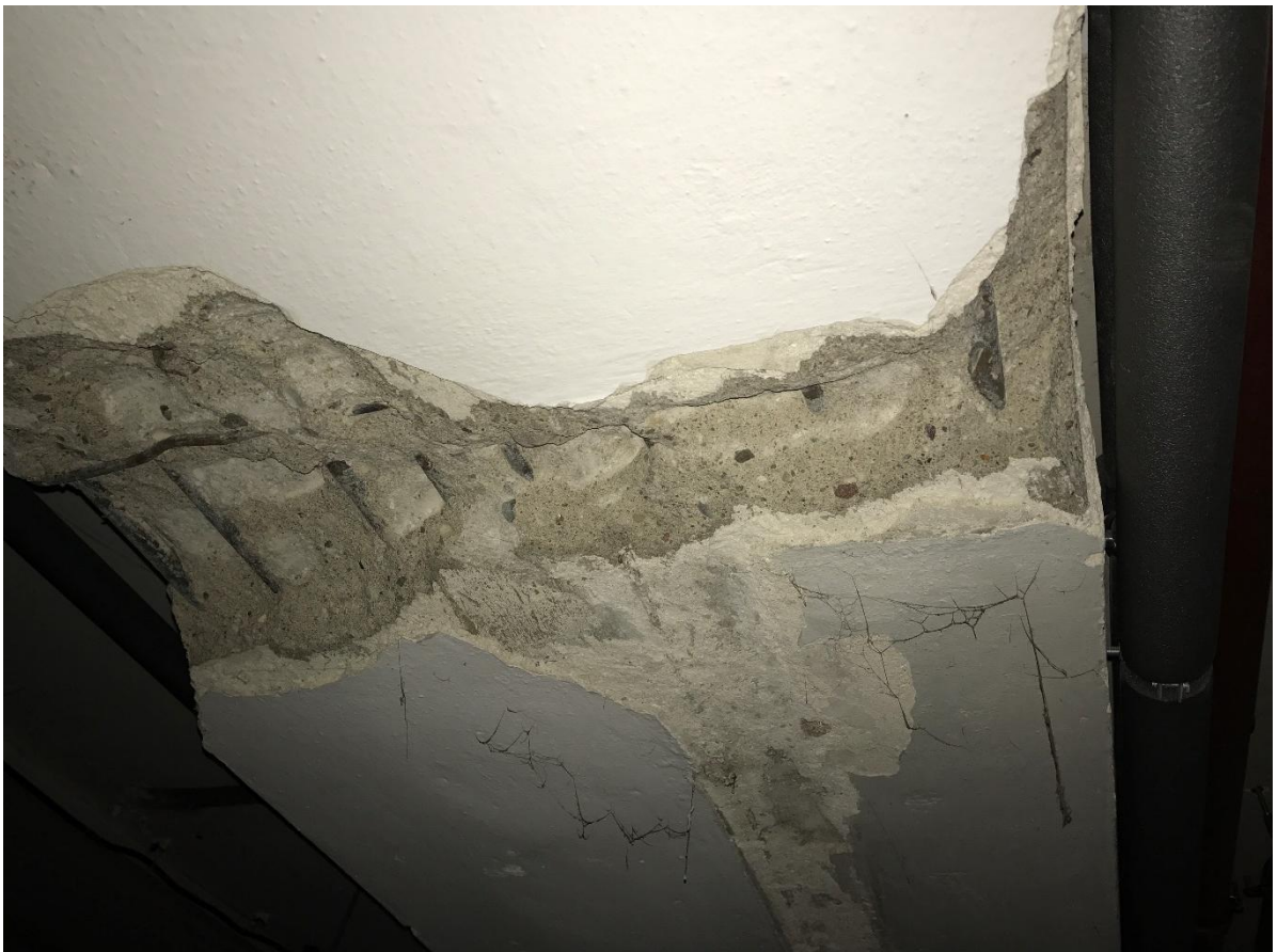
Fot. F-6 Podciąg monolityczny P2-odkrywka nr4
