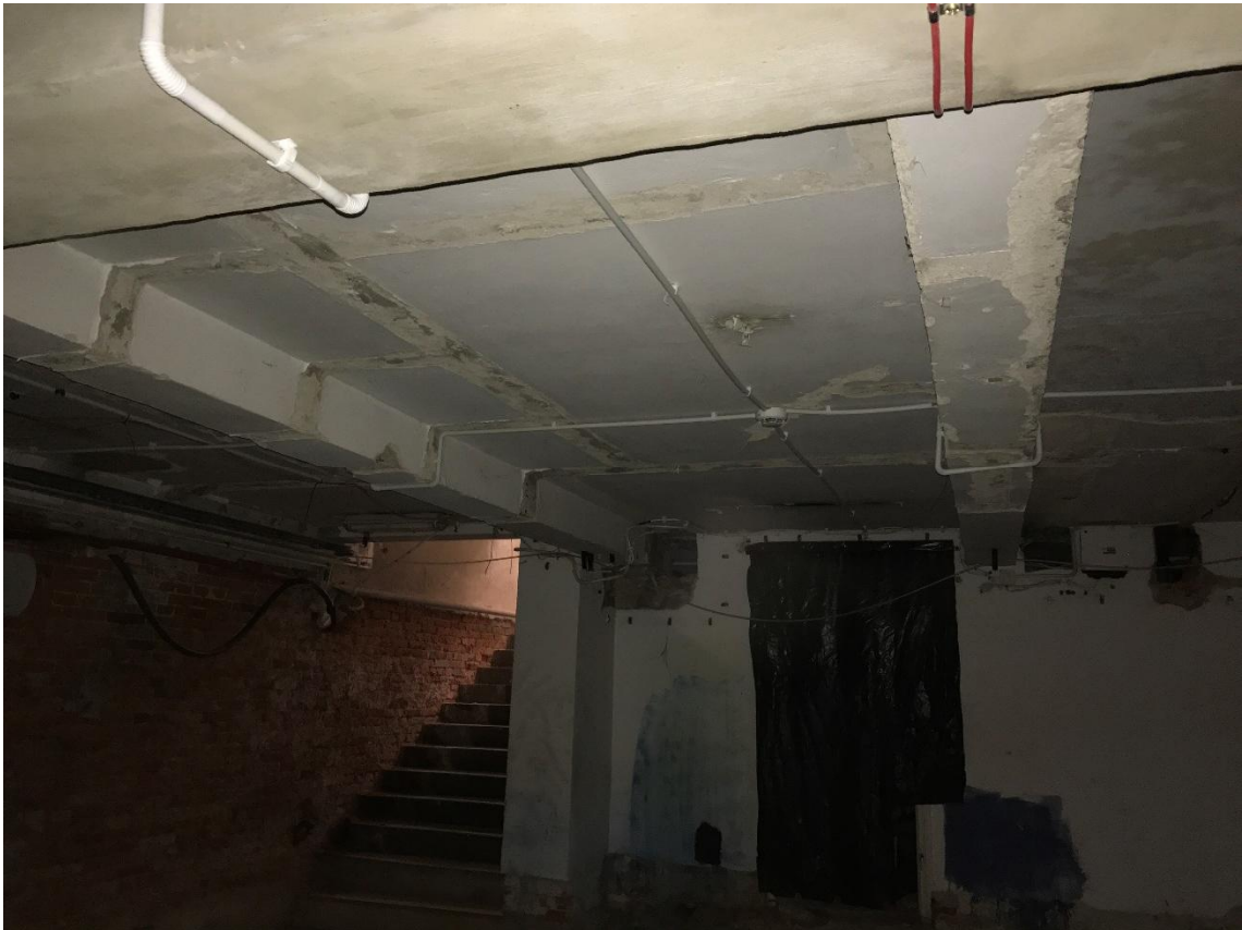
Fot. F-1 Widok płyty stropowej PŁ1 i belek monolitycznych B1
